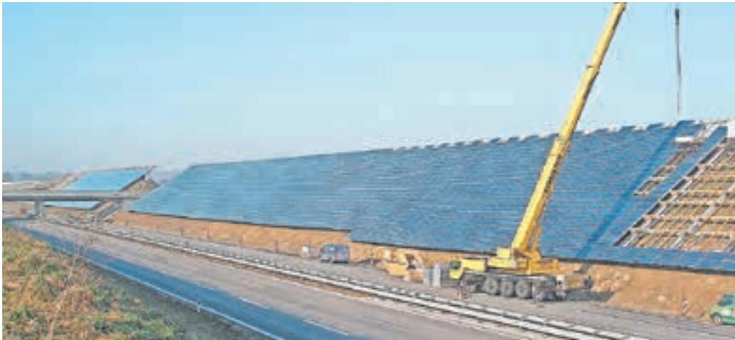
Mit Solarzellen an Lärmschutzwänden könnte viel Strom produziert werden. (Bild: PD)
